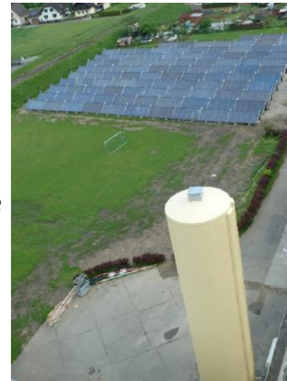
Chaudière solaire pour la brasserie de Göss
