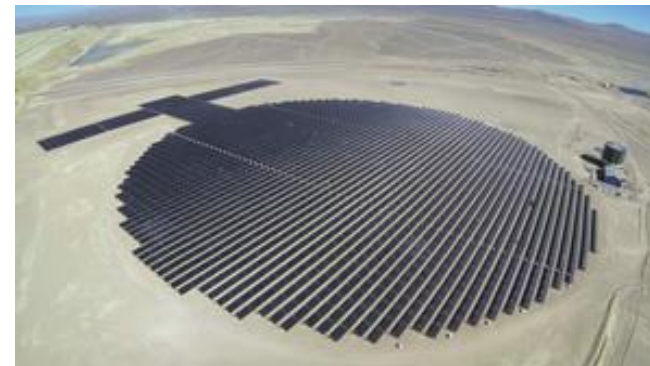
Pampa Elvira Solar, chaudière solaire pour Codelco
