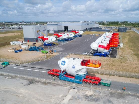
St Nazaire : Construction des génératrices et assemblage des nacelles
